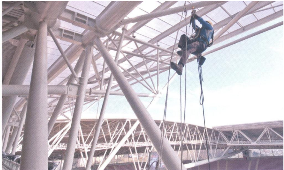
Hohes Risiko: Handwerker haben oft einen gefährlichen Job.
